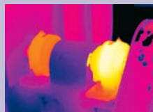
Перегрев крышки подшипника
